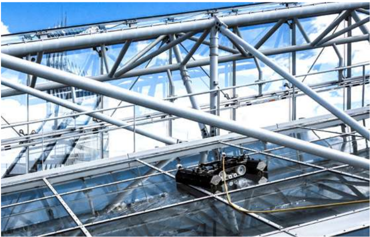
También adecuado para la limpieza de ventanas y techos de cristal
